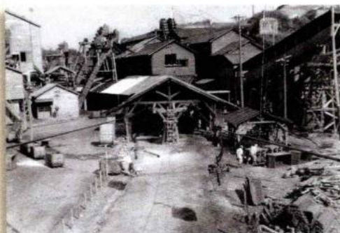
●西杵炭鉱ケーブル
