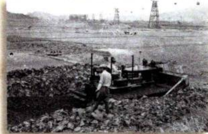
●昭和36年頃の鉱害復旧作業
