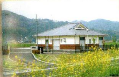
●橋下地区浄化センター(平成15年)
