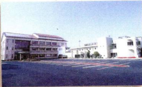
●新庁舎落成(北方町役場) 約2年の工期を経て平成8年に完成した。
