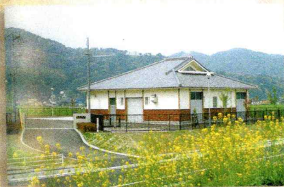
●橋下地区浄化センター(平成15年)
