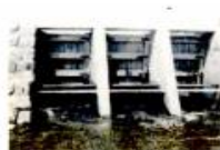
放水門（回転扉）
