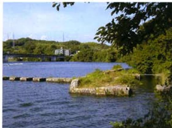
旧船通しの工作図(タタキと呼ばれる人造石で築造)
